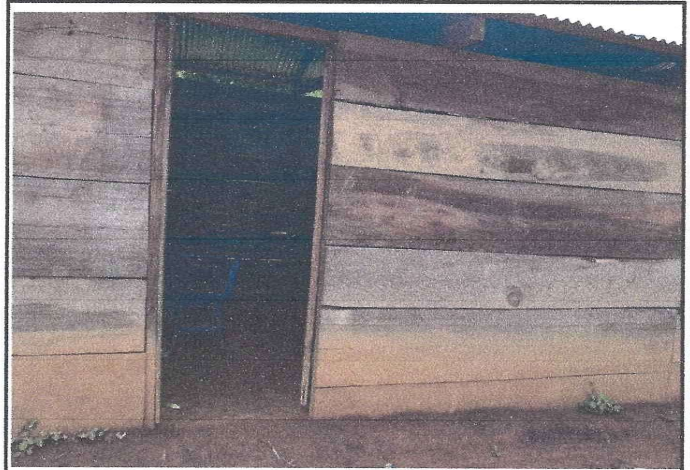
Foto 2: MEJORAMIENTO DE PUERTAS Y VENTANAS
