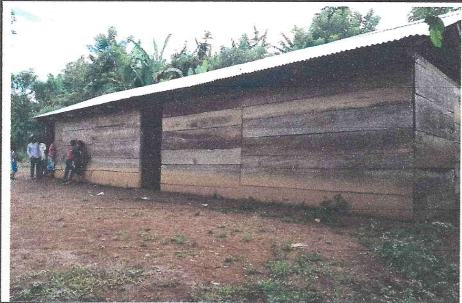
Foto 3: MEJORAMIENTO DE AULA
