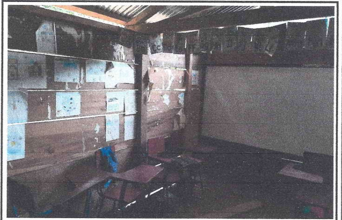
Foto 4: MEJORAMIENTO DE PARED Y PISO
